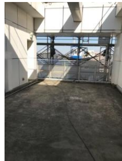
オフィス物件時の屋上
